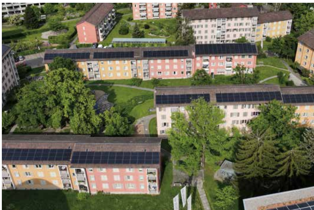
Die Solarpanels auf den Dächern von Else Züblin versorgen die Siedlung mit grünem Strom.
